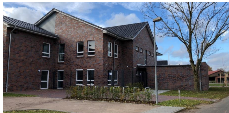
Abbildung 57: Blick auf den Anbau von der Segeberger Straße (cima 2021)
